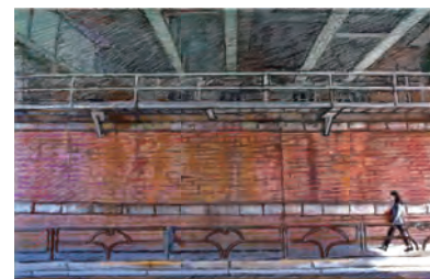
1 大塚架道橋 豊島区遺産、いや東京都遺産と推したがる人が多いという明治35(1902)年築の架道橋。鉄道の歴史から煉瓦はイギリス積みも継承している。
