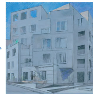
5 「Treform (トレフォルム)」 3人の建築家(千葉学、小川晋一、西沢立衛)によるコラボレーション集合住宅。
